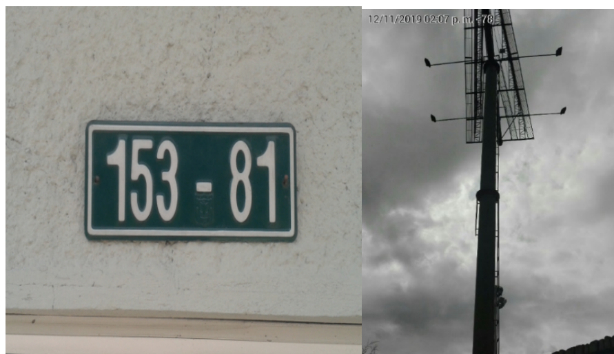
Foto No. 3 y 4: Nomenclatura del predio y detalles de la estructura y mastil de la valla tubular, en buenas condiciones y estable, instalada en la Av. Carrera 45 No. 153-81 (dirección catastral), orientación Sur-Norte .
