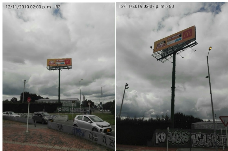
Foto No.1 y 2: Vista panorámica del predio, del panel y de la estructura de la valla, ubicada en la Av. Carrera 45 No. 153-81 (dirección catastral), orientación Sur-Norte .
